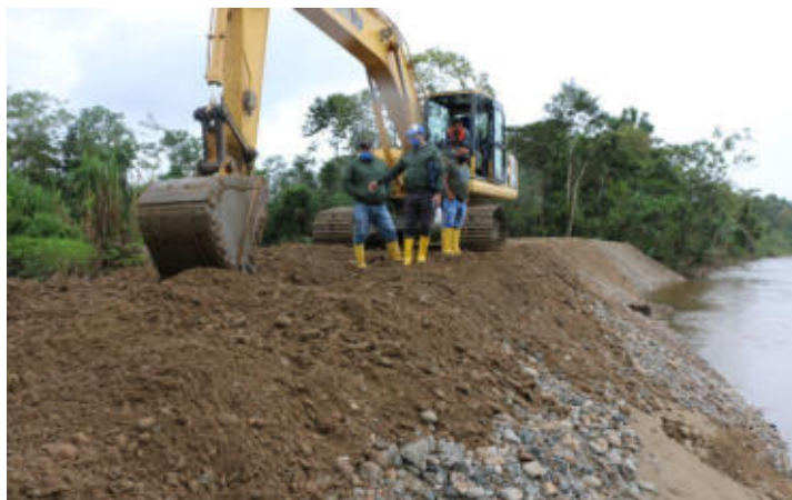
Construcción de muros de protección en las riveras del Rio Nangaritza – sector Nuevo Santa Elena
