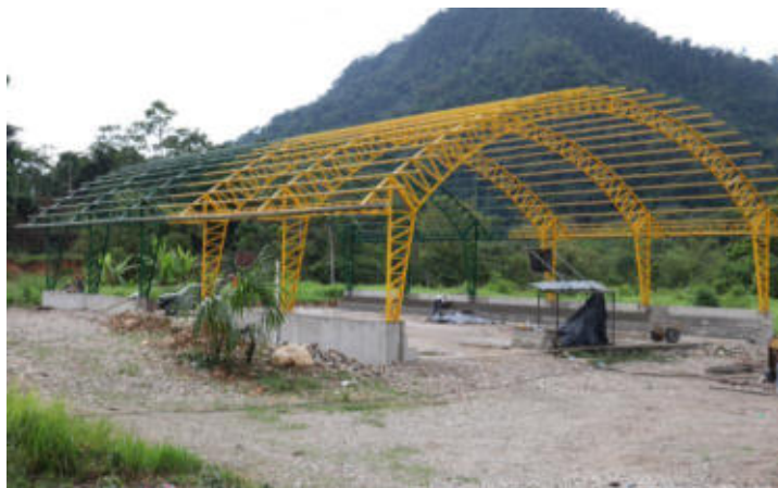
Construcción de la cubierta metálica en la cancha de uso múltiple del barrio La Wantza.
