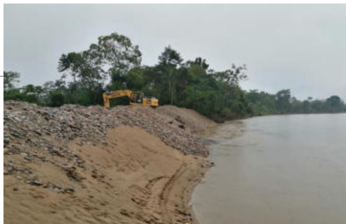
Construcción de muros de protección en las riveras del Rio Nangaritza – sector Nuevo Santa Elena
