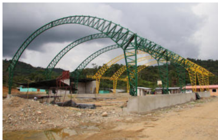
Construcción de la cubierta metálica en la cancha de uso múltiple de Shamatak.
