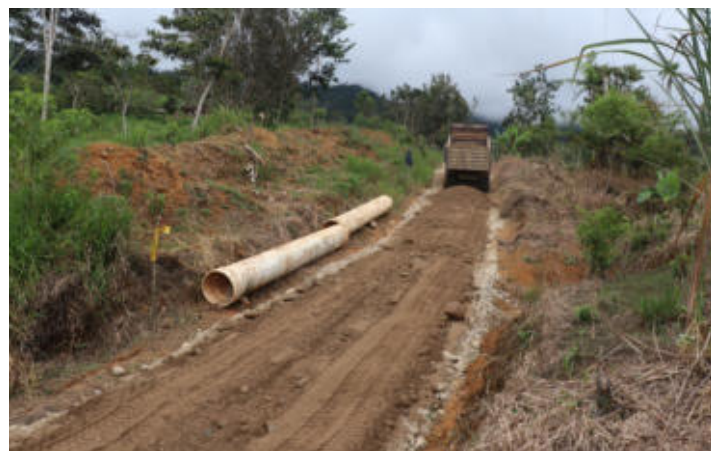
Lastrado de la vía Pantaña - San Roque.
