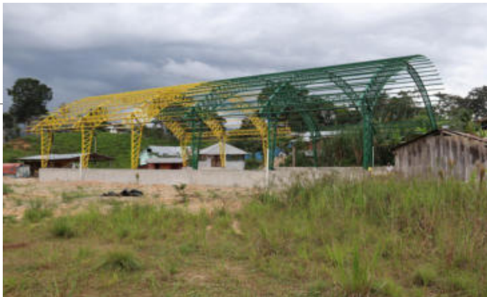
Construcción de la cubierta metálica en la cancha de uso múltiple del barrio San Ramón.
