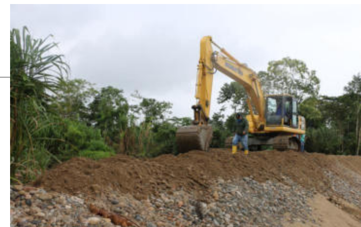
Construcción de muros de protección en las riveras del Rio Nangaritza – sector Nuevo Santa Elena
