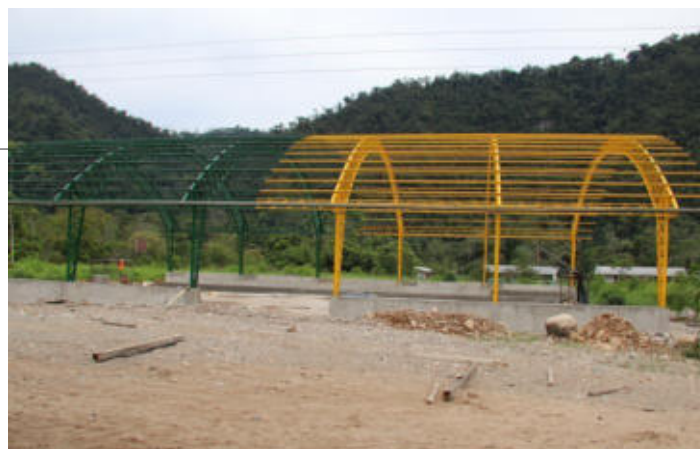
Construcción de la cubierta metálica en la cancha de uso múltiple del barrio La Wantza.
