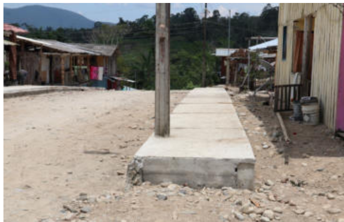
Construcción de aceras y bordillos en la cabecera parroquial de Nuevo Paraíso.
