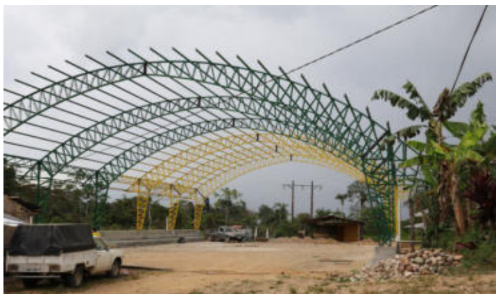
Construcción de la cubierta metálica en la cancha de uso múltiple del barrio San Ramón.
