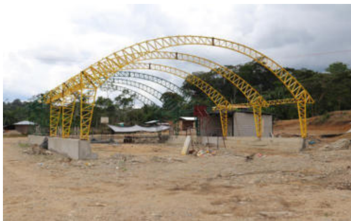
Construcción de la cubierta metálica en la cancha de uso múltiple de Shamatak.
